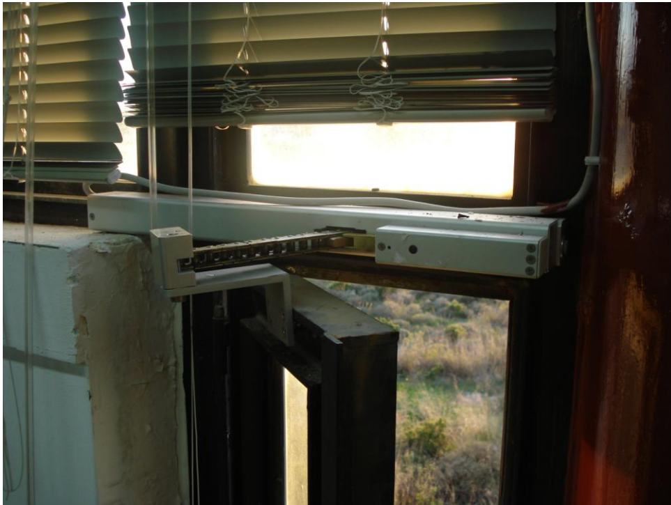
Εικόνα 3.11 Παράθυρο με μηχανισμό ανοίγματος στο εργαστήριο
